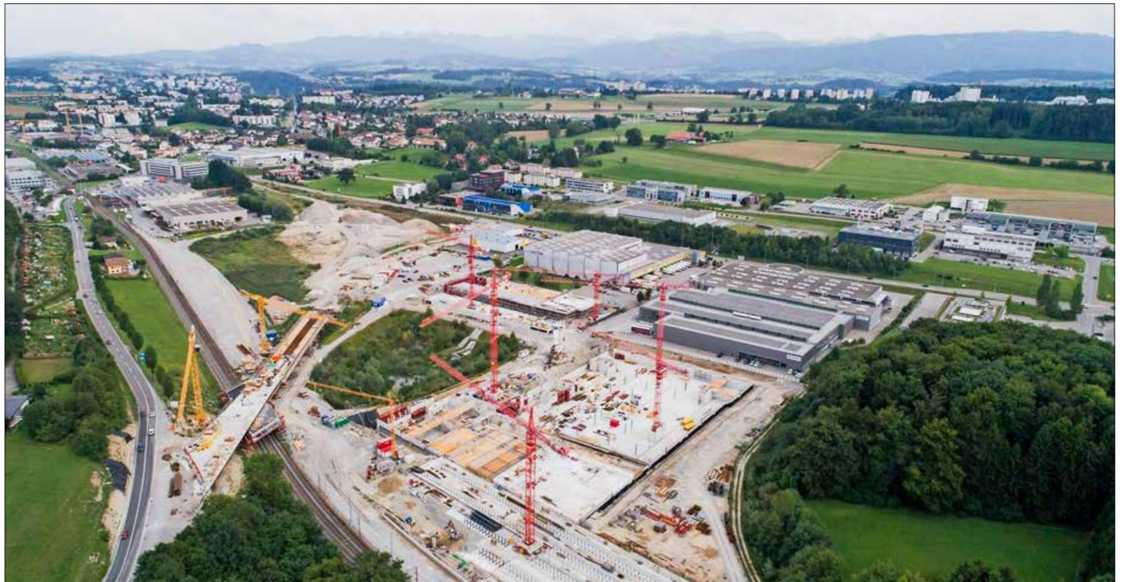
Vu du ciel, le chantier du centre de Givisiez révèle toute son ampleur. Au premier plan, on aperçoit le futur pont du Tiguellet, avec un peu plus bas les ateliers de maintenance ferroviaire. Dans leur prolongement, le dépôt et les installations de réparation des bus. Plus haut, le rez-de-chaussée du bâtiment administratif est déjà bien avancé. CHLOÉ LAMBERT
